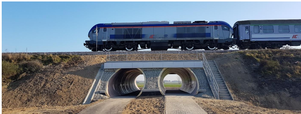
Ukończone przejście pieszo - rowerowe pod torami linii kolejowej nr 30 Łuków – Lublin Północ
