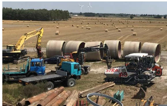
Kręgi tunelu dostarczone na miejsce budowy
