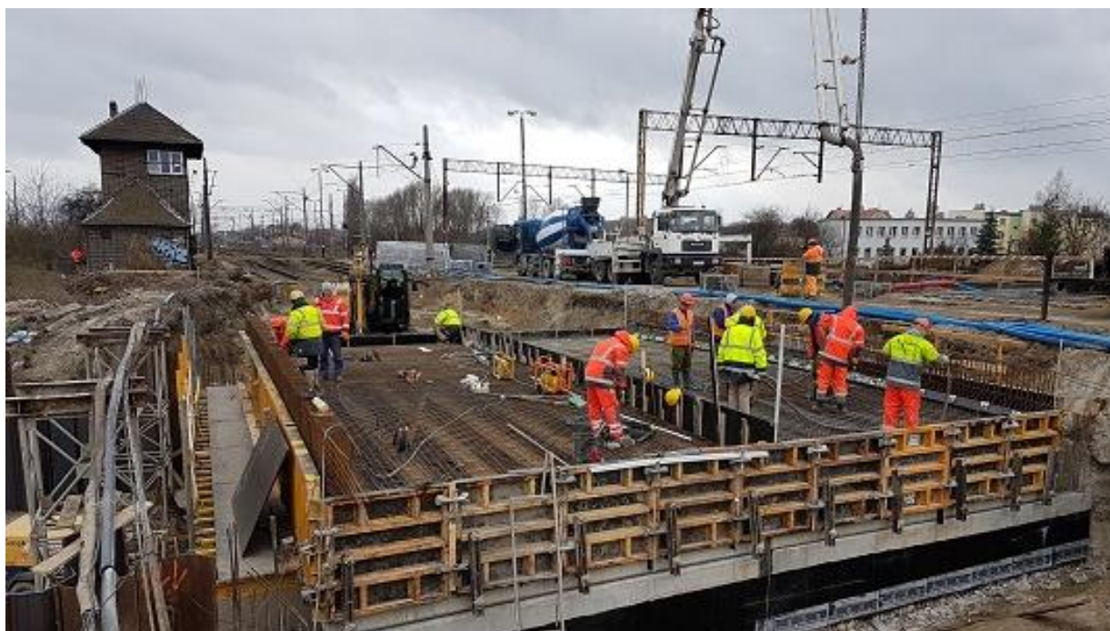
Prace przy konstrukcji wiaduktu
