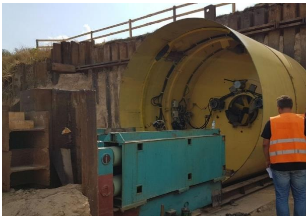
Prace przy budowie tuneli
