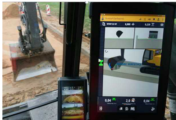
System Trimble Earthworks wspiera pracę operatora
