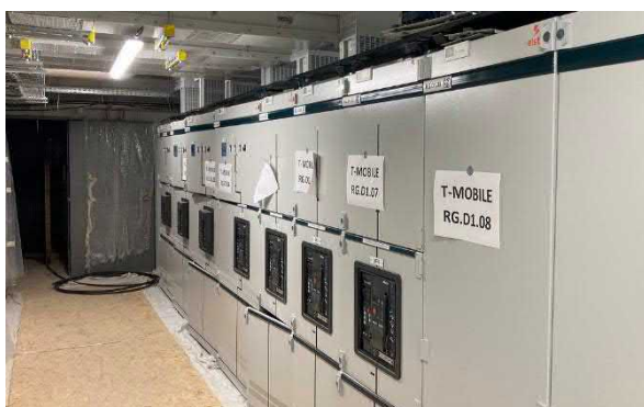
Widok serwerowni przed i po zainstalowaniu urządzeń
