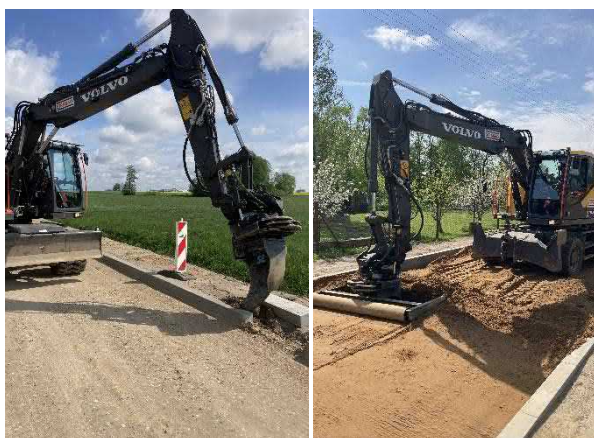
Zęb zrywający i belka wyrównująca podczas prac
