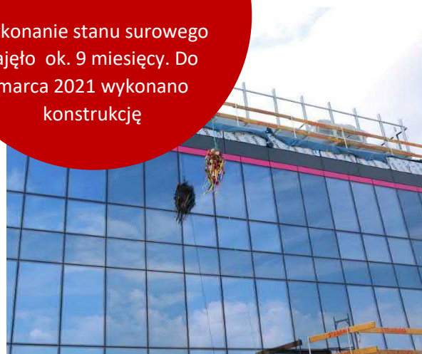
Sprawną realizacją i szybkie tempo prac
