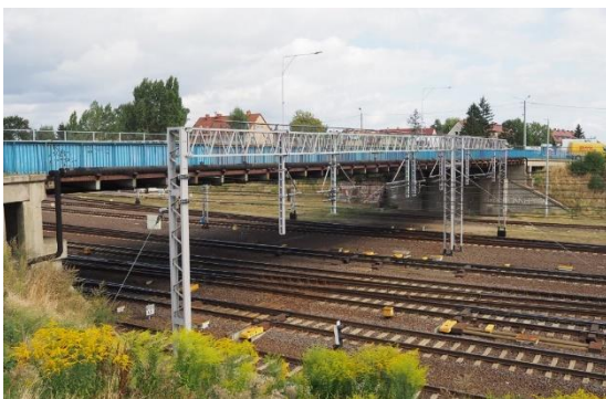
Stary wiadukt przed rozpoczęciem prac demontażowych
