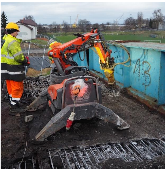
Prace rozbiórkowe na konstrukcji zsuniętego wiaduktu
