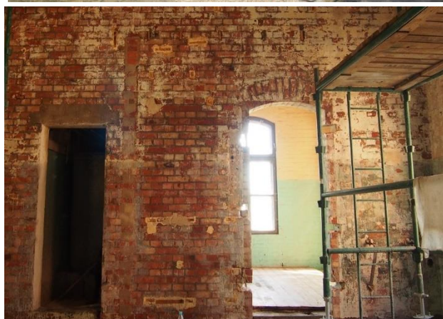
Śluza Północna i budynek maszynowni w trakcie prac
