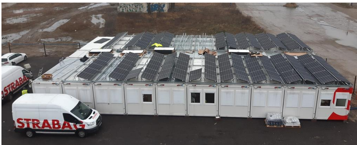
Zaplecze budowy linii tramwajowej na ul. Kasprzaka w Warszawie wyposażone z panele fotowoltaiczne
