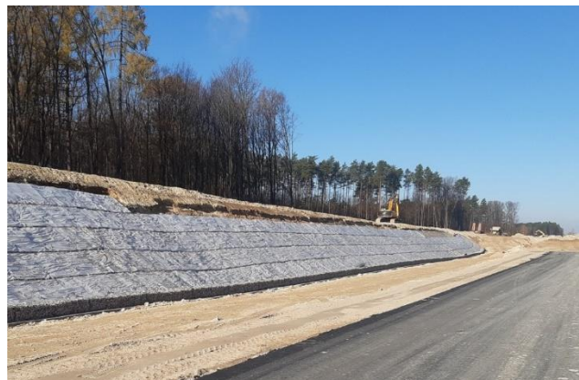
(u góry) Układanie geosyntetyku o wysokiej wytrzymałości, (środek) wykonywanie iniekcji niskociśnieniowych, (dół) wzmocnienie skarpy matercem gabionowym i gwoździami
