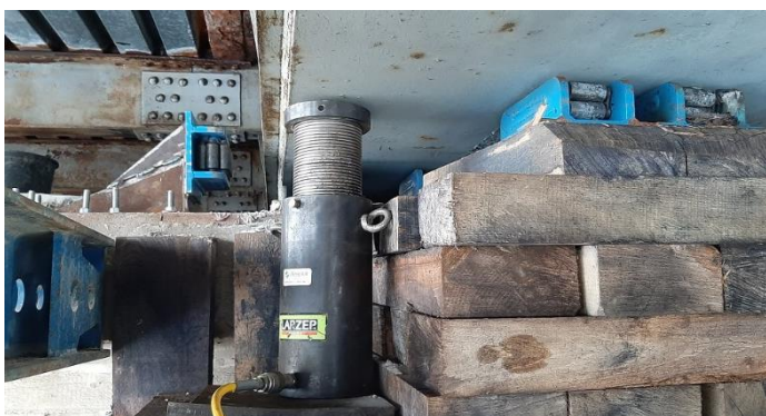
Zsuwanie płyty wiaduktu przy wykorzystaniu systemu podpór i siłowników hydraulicznych
