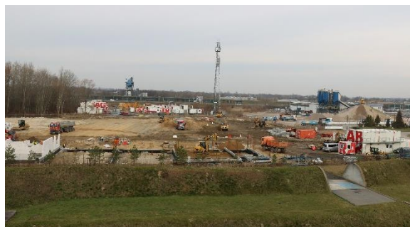
Widok na plac budowy z okien siedziby STRABAG w Pruszkowie, marzec 2020 r.
