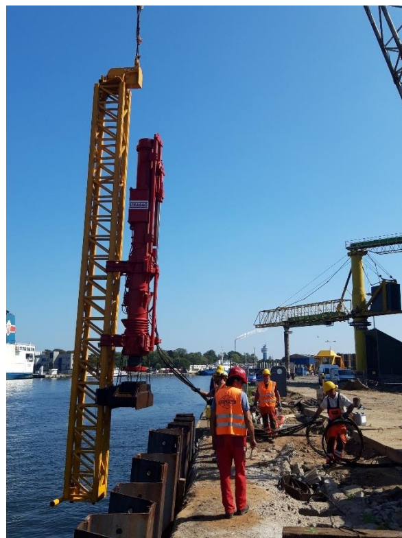
Młot spalinowy Delmag D30 – 52
