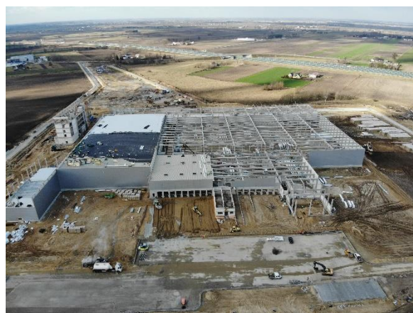
Budowa Centrum Logistycznego w Wiskitkach, luty 2020 r.
