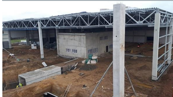
Rozbudowywana hala zakładu produkcyjnego Terma
