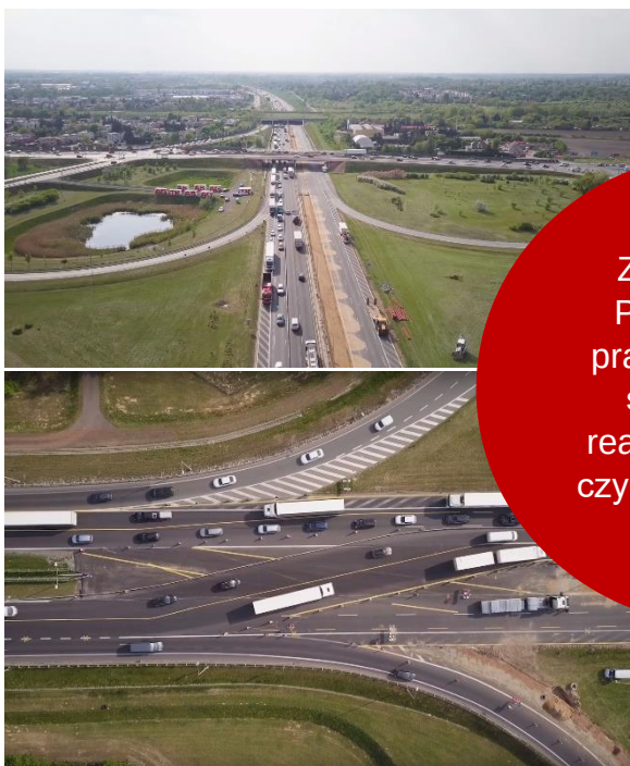
Autostradowa obwodnica Poznania w trakcie rozbudowy, fot. Maciej Nowaczyk
