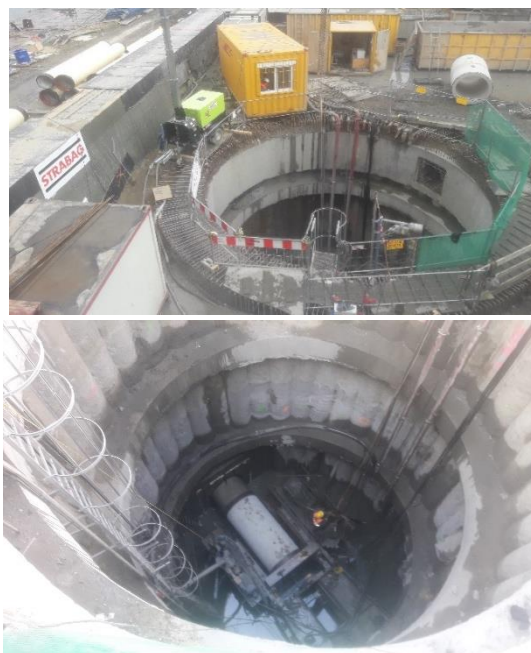
Fot. 1 (góra) Komora nadawcza K-1 – widok z sąsiedniego mostu kolejowego.
