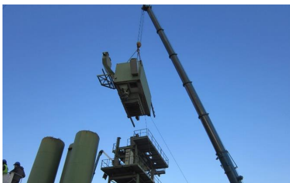
WMB w trakcie prac montażowych
