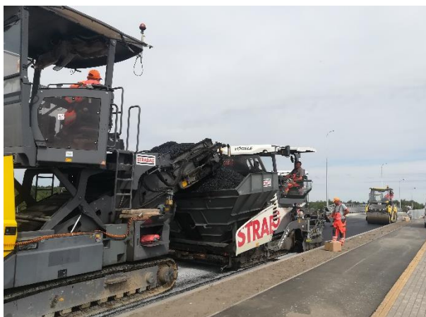
S8 – obwodnica Marek, prace przy układaniu nawierzchni
