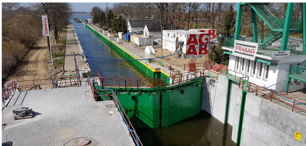
Śluza Południowa – z zamkniętymi wrótami
