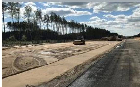
Prace budowlane na DW 604
