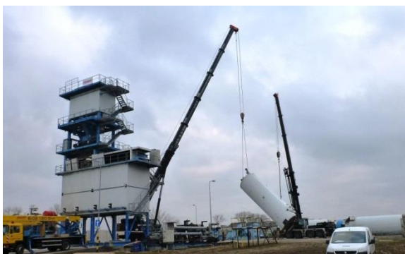
WMB w trakcie prac montażowych
