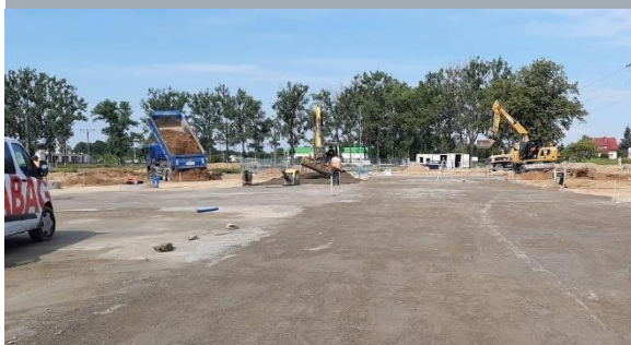
Prace budowlane na ul. Żeglarskiej
