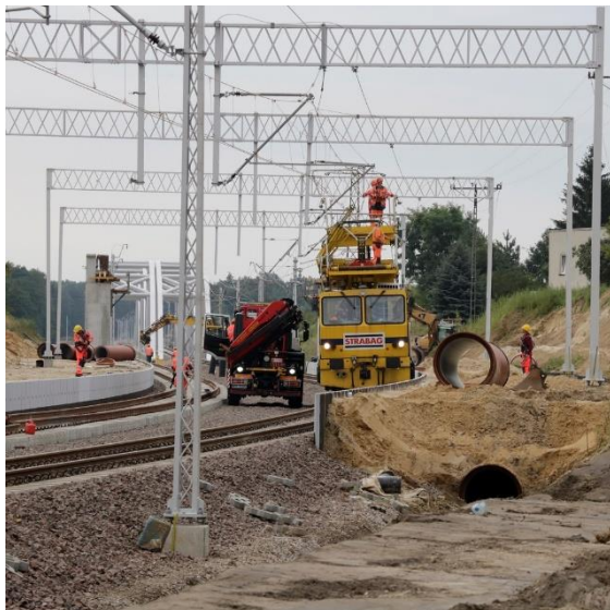
Montaż sieci trakcyjnej przez Grupę Sieciową
