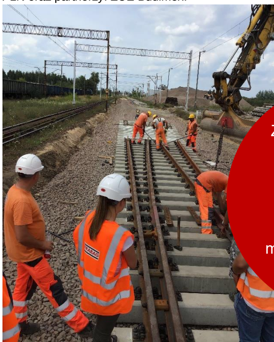
Prace przy układaniu toru
