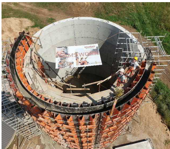
Wiecha na budowie w Grajewie
