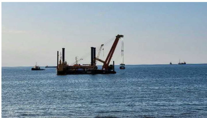
Dźwig pływający na pontonie wyciąga TBM
