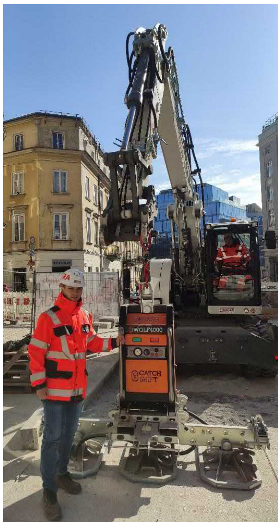
Dawid Janulewicz na budowie Placu Pięciu Rogów w Warszawie przy urządzeniu WOLF
