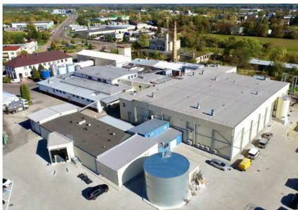
Rozbudowa zakładu produkcyjnego Mlekovita w Białej Podlaskiej
