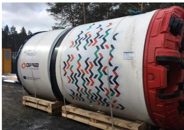
Rozładunek TBM na placu budowy
