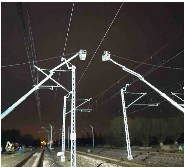
Nocny demontaż sieci energetycznej.
