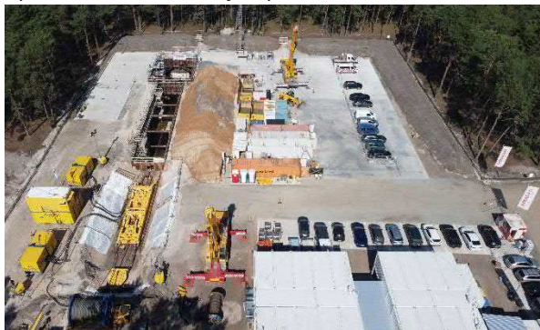
Widok z lotu ptaka na miejsce startowe drążenia tunelu
