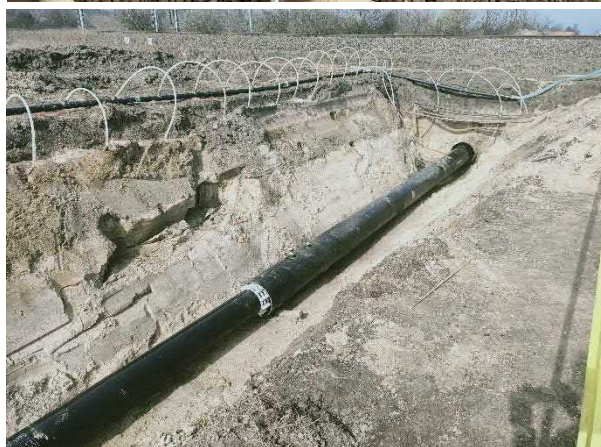
Zamontowane na torze konstrukcje odciążające (górne fot.) oraz przecisk, w którym poprowadzony jest gazociąg, w nasypie widoczne są zapłukane igłofiltry (dolne fot.).
