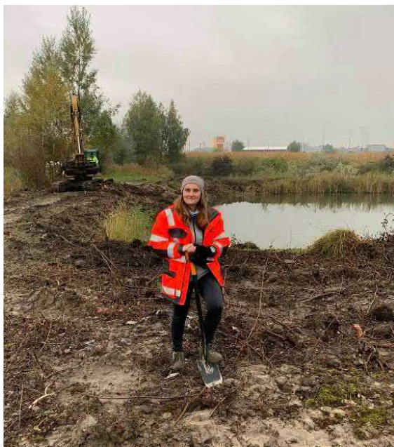
Dorota Mondorowicz – Lisiecka inauguruje prace na odcinku, gdzie Glinianki Natolińskie przecina nowa trasa DW 579.
