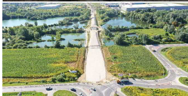
Kolejne etapy prac przy powstawaniu drogi na terenie Glinianek Natolińskich
