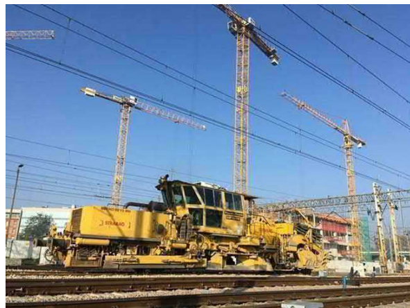
Profilarka tłuczni Plasser & Theurer SSP 110SW – Kraków, rok 2019
