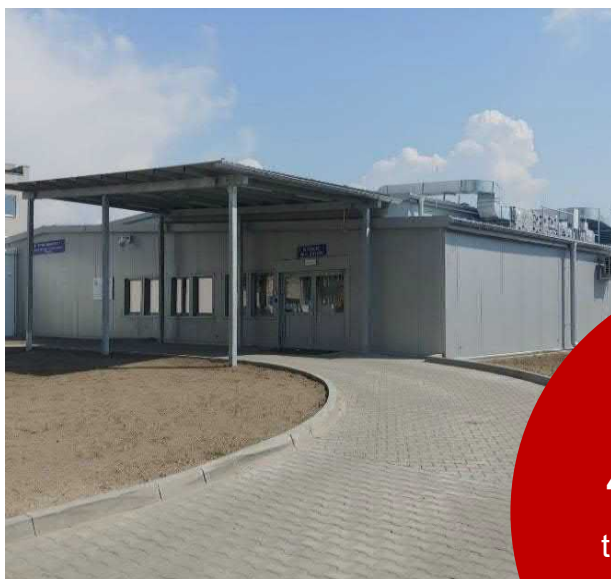
Gotowy szpital, przy budowie którego prace trwały dzień i noc.
