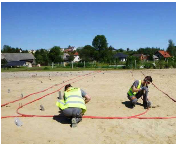
Instalacja czujnika SHM Profiler na realizowanej obwodnicy Tuchowa
