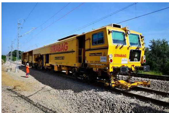
Praca podbijkarki torowej na budowie linii E30 w Krakowie
