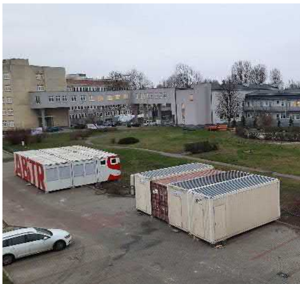
Powstający szpital (1. dzień budowy)
