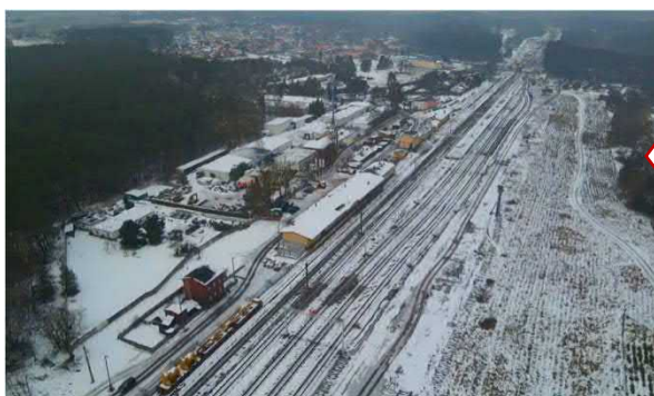
Stacja Drawski Młyn. Powyżej podbijanie toru nr 1 przy peronie
