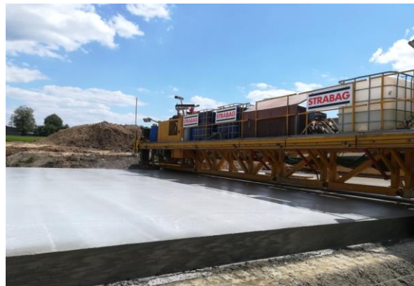
Autostrada A1, odc. H w trakcie budowy
