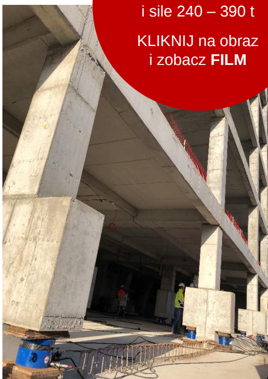
Siłowniki podczas lewarowania obiektu oraz panel sterujący (górne zdjęcie)
