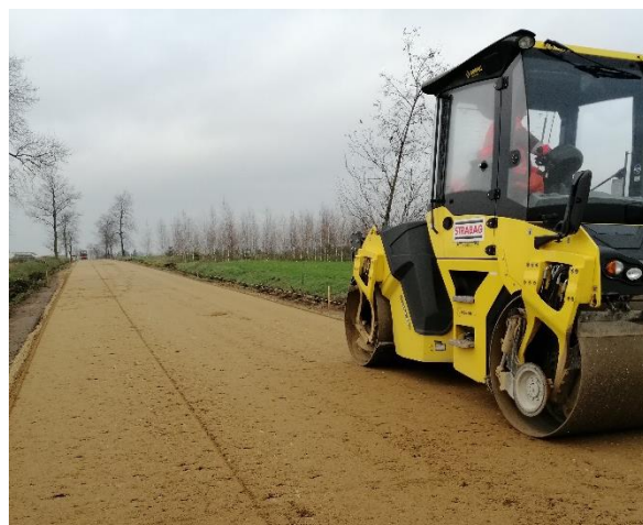
Obecnie pracuję na stanowisku Kierownika Robót i można mnie spotkać na północnym Mazowszu
