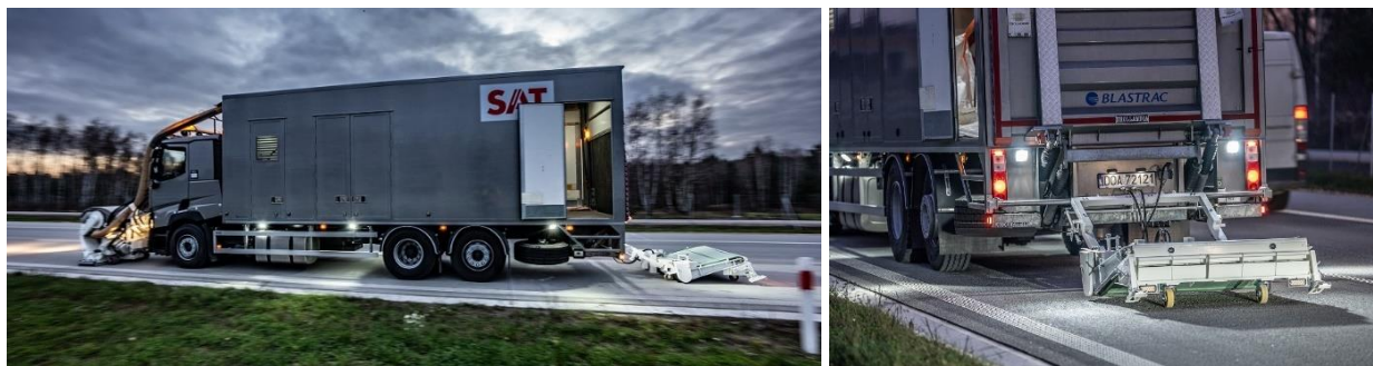
Śrutowanie drogi ekspresowej S17, odc. Warszawa – Kołbiel
