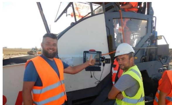
Od prawej: Adam Żuk - Kierownik Budowy i Arkadiusz Szejbak - Majster Robót Bitumicznych na budowie obwodnicy Kępna (S11)
