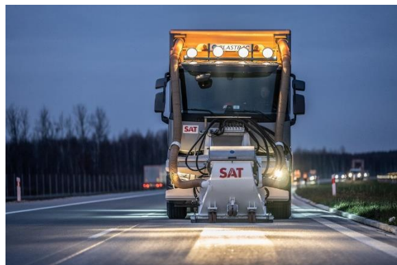
Śrutowanie drogi ekspresowej S17, odc. Warszawa – Kołbiel
