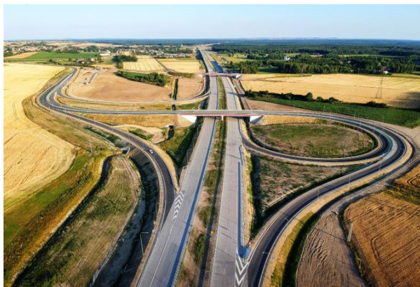
Ukończony odc. H autostrady A1
