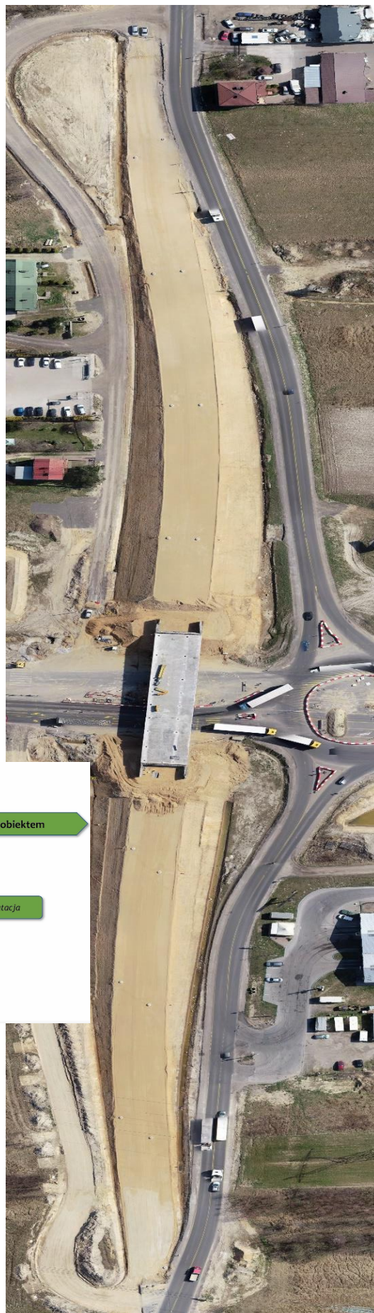
WD-332 w ciągu autostrady A1 (k. Radomska)
